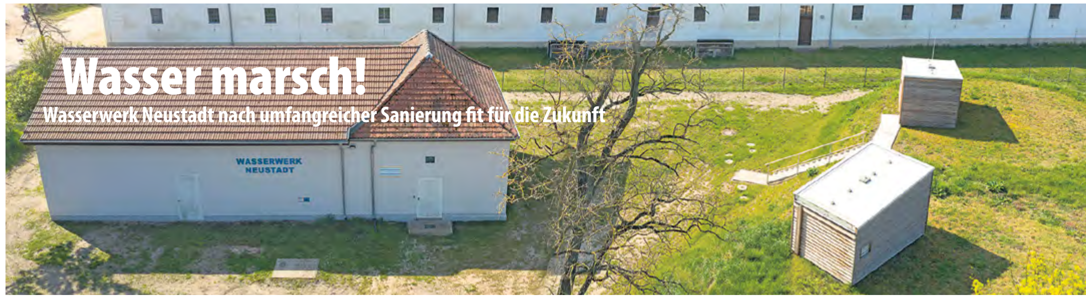
Das Wasserwerk Neustadt ist eines von acht Wasserwerken im Verbandsgebiet. Von hier aus erhalten die Einwohner von Neustadt, Sieversdorf und Hohenofen ihr Trinkwasser.
