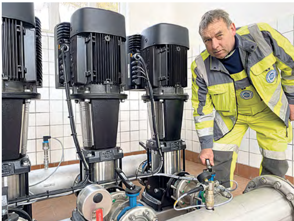
Ein prüfender Blick auf den neuen Pumpenblock. Wasserwerker Jürgen Kube ist zufrieden: Alles läuft im grünen Bereich.
